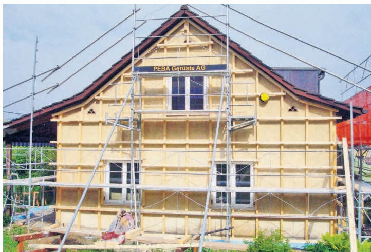
Zuerst sollte die Gebäudehülle gut isoliert sein, bevor es sich lohnt, die Haustechnik und die Heizung zu erneuern.
