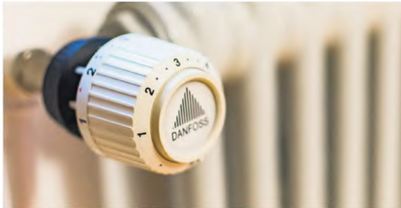
Heutzutage gehört an jeden Heizkörper ein solches Thermostatventil, das auch nachträglich angebracht werden kann.
